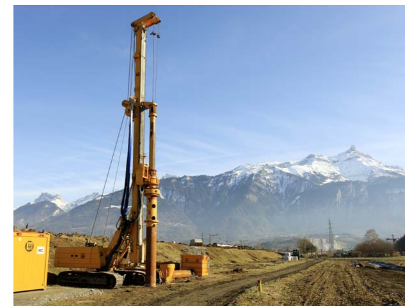
Les travaux préparatoires ont débuté en novembre 2011. Ils englobent notamment la modification des routes d'accès et le renforcement de la voie CFF du Tonkin.
