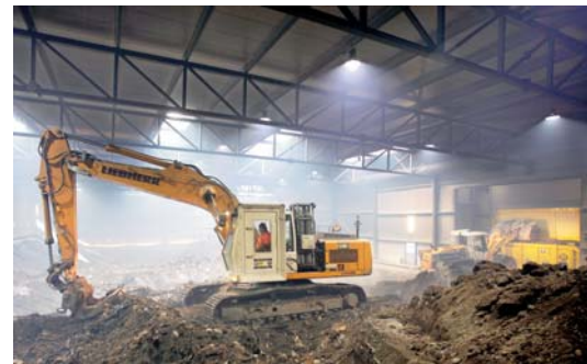
Excavation dans la halle et chargement des matériaux dans des containers étanches.
