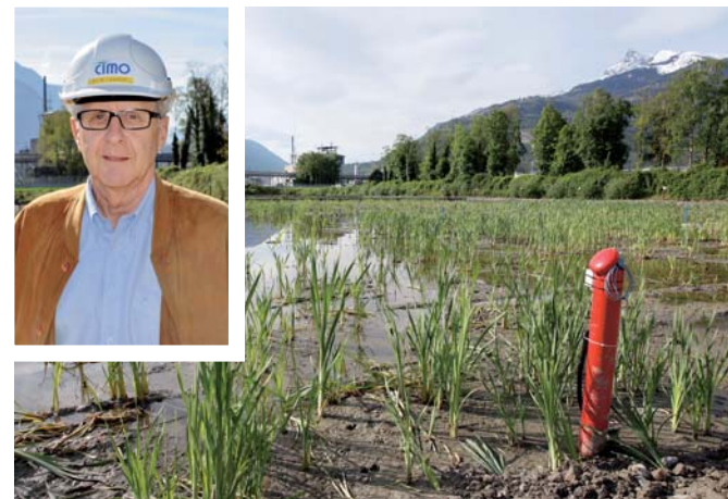
Ci-dessus: Eric-Bernard Meier. Près de 80 sondes ont été installées dans l'ancien étang de la STEP afin d'éliminer les dernières traces de polluants, explique Eric-Bernard Meier, chef de projet pour Cimo.
