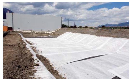
En parallèle, les zones assainies sont remblayées avec des matériaux d'excavation propres, issus des chantiers de la région.
