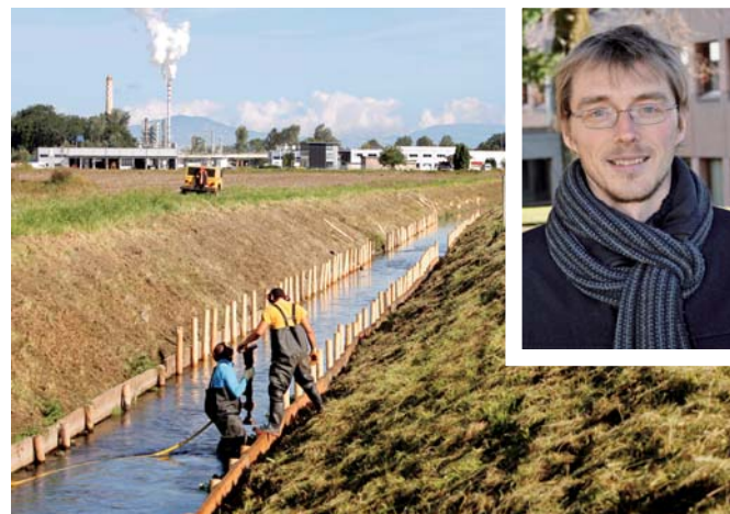
Ci-dessus: Gilles Fasel. Les travaux de curage des cours d'eau ont duré cinq mois. 5600 m 3 de matériaux ont été excavés précise Gilles Fasel, chef de projet pour Cimo.
